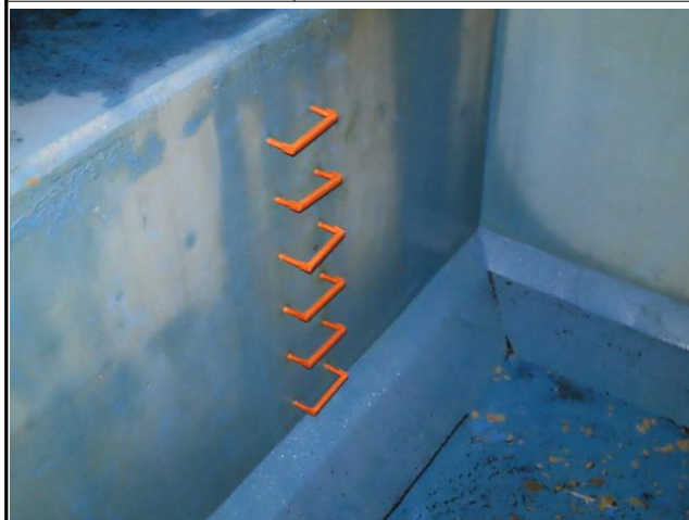
공중이용시설 집수정 사다리 상태양호
