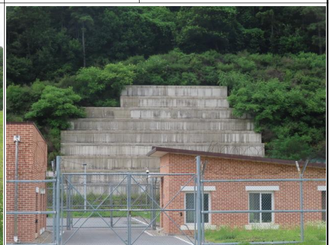
외부사면 및 옹벽
